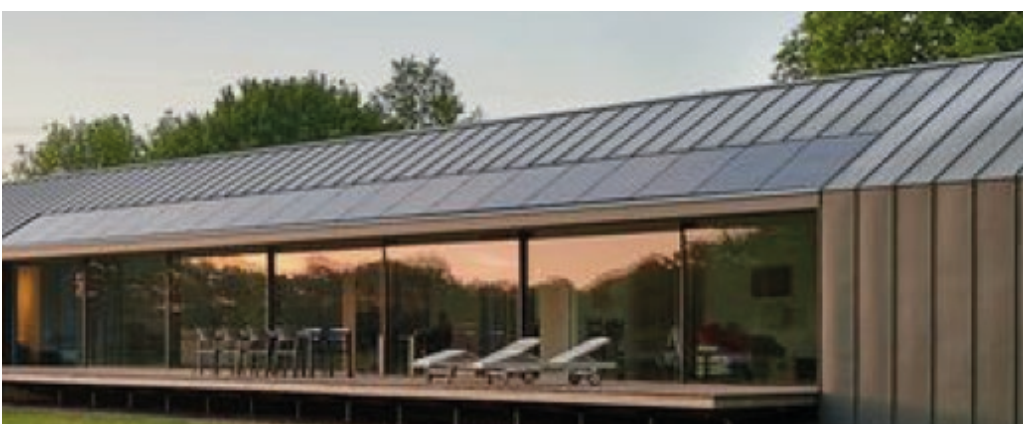
referentiebeeld pv-cellen zijn verwerkt in de architectuur
