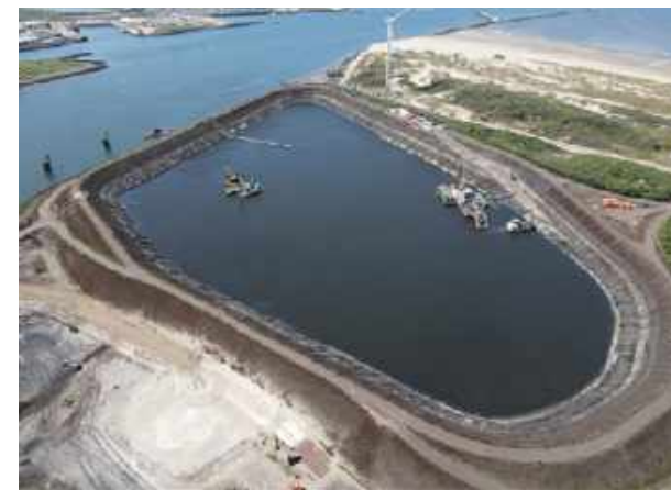
Toezicht Averijhaven IJmuiden vanuit de lucht
