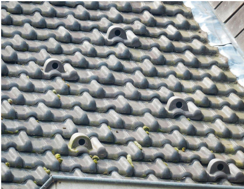
Dakpannen met ingebouwde vogelkastjes. Let op! Kan alleen toegepast worden bij daken aan de noordzijde met een hoek van minimaal 45° in verband met hitte.
