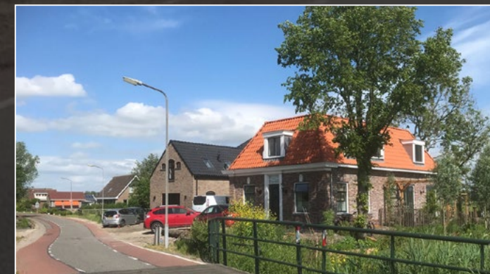
De Haal 78, aanzicht vanaf de zuidwestzijde met de nieuwe woning
