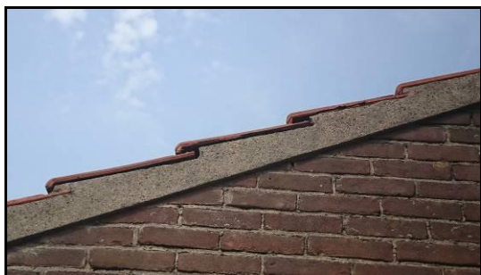
Afbeelding 6: ruimtes onder dakpannen
